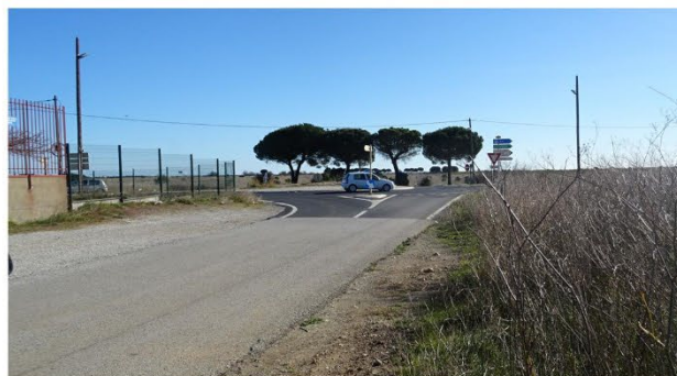
3. Carrefour giratoire du pôle vinicole sur la RD900.
