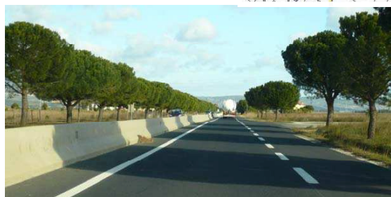
3 La RD 900 en provenance du Sud. Le double alignement de pins parasols structurant l'itinéraire . A droite le site du projet de « Circuit Roussillon »
