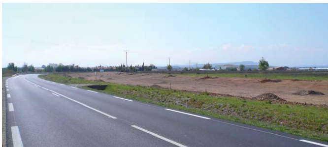
1 La RD 5 - Bassin de rétention de la zone artisanale récemment réalisé, en cours de plantation
