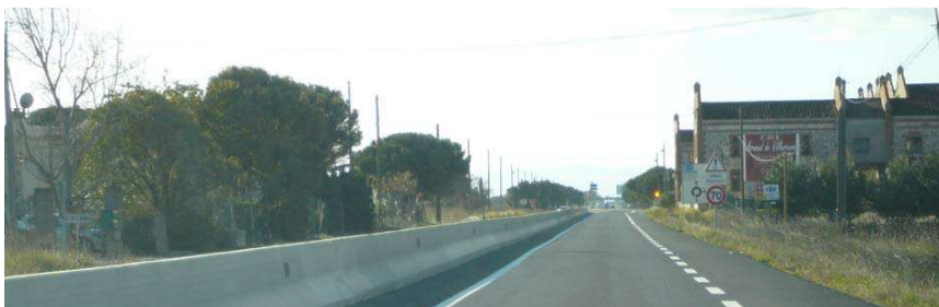
2 La RD 900 en provenance de Salses. A droite les bâtiments imposants de la cave. A gauche le « parc » d'un habitat isolé
