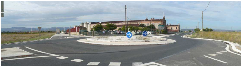
1 RD 900 - Carrefour de « la Cave » devant être réaménagé dans le cadre du projet de « sécurisation entre le péage Nord et Salses » comprenant aussi la réalisation d'une voie latérale avec un circuit cyclable à l'Ouest de la chaussée
