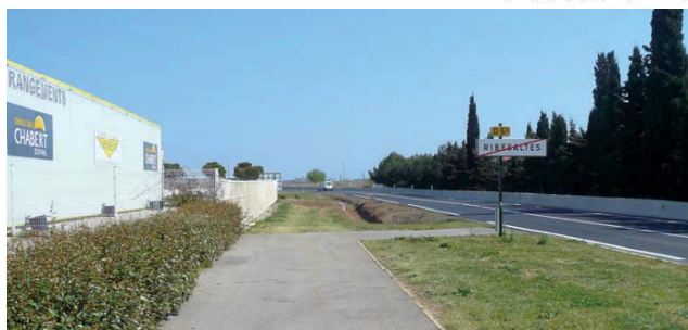
3 La RD 5 en sortie d'agglomération - Origine actuelle de la piste cyclable le long de la zone artisanale et l'emprise de son prolongement vers le nord
